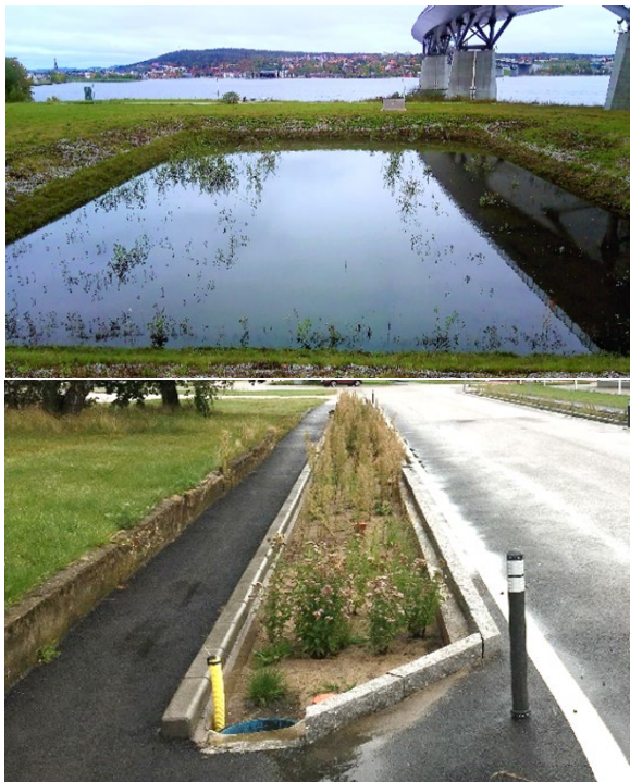
Bild 5. Biofilter för dagvattenbehandling i Sundsvall (övre bild) samt Växjö (nedre bild), efter ett nederbördstillfälle.
