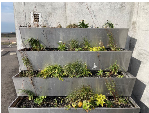
Bild 17. Ny experimentell grön vägg installerad i RecoLab, Helsingborg.
